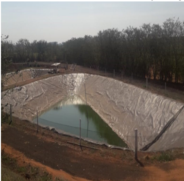
Aterro Sanitário Seleta: Aplicação de lona para escoamento da água da chuva
