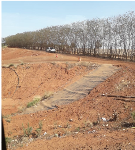
Aterro Sanitário Seleta: Aplicação de lona para escoamento da água da chuva
