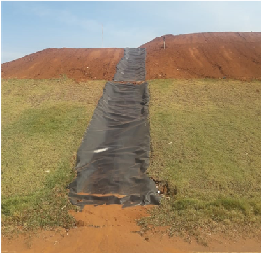
Aterro Sanitário Seleta: Aplicação de lona para escoamento da água da chuva
